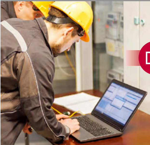
Im Büro des Installateurs
